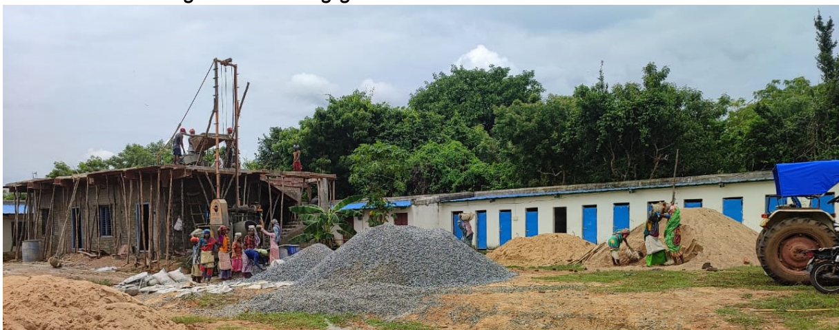
Mit dem Traktor wird eine Fuhre Steine geliefert und abgeladen (oben). Unten die Baustelle mit einem der beiden neuen Häuser auf dem Heimgelände in Bada Kusumi bei Berhampur im Rohbau. Sie sollen zur Unterbringung der Kinder dienen. Gerade wird die Decke mit dem vor Ort gemischten Beton gegossen. Im Hintergrund sind die bereits seit längerer Zeit fertig gestellten Toiletten und Waschräume zu sehen
