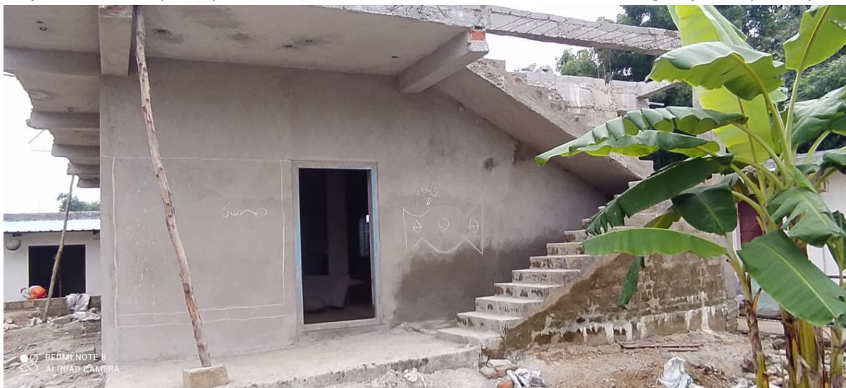
Eines der beiden Häuser für die Kinder mit dem seitlichen Treppenaufgang bei Verputzarbeiten (oben) und nach Abschluss dieser Arbeiten fünf Tage später (unten)
