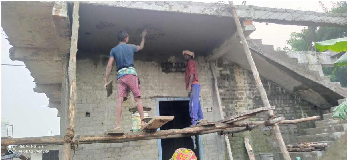
Eines der beiden Häuser für die Kinder mit dem seitlichen Treppenaufgang bei Verputzarbeiten (oben) und nach Abschluss dieser Arbeiten fünf Tage später (unten)
