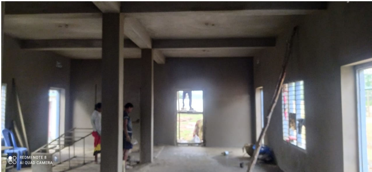
Das neue Haus von innen, der Raum soll später als Schlafraum genutzt werden
